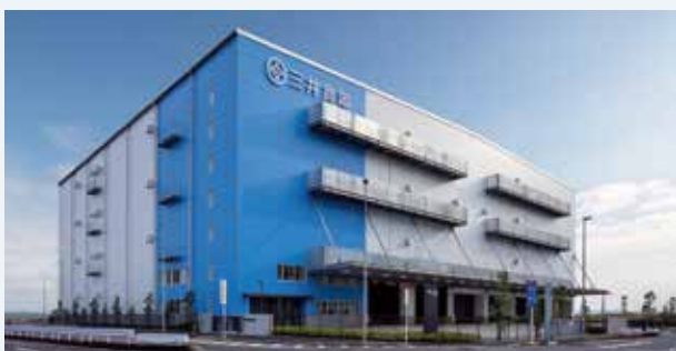
CASBEEのAランクを取得した三井倉庫(株)南本牧倉庫
