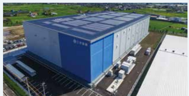
太陽光パネルやLED照明を導入した三井倉庫(株)関東P&Mセンター
